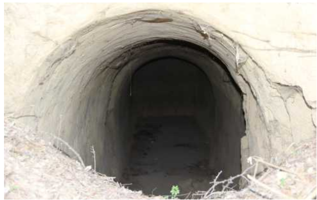
Die in den Löss gegrabenen Kellergewölbe sind auch ohne Stützmauern erstaunlich stabil.
